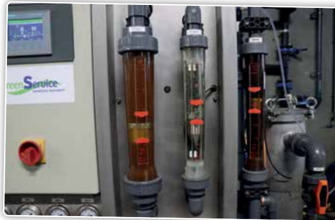
Rechts de ingaande stroom, midden gefilterd water en links het mineralenconcentraat.
