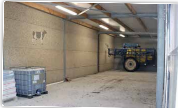
Omdat er te weinig ruimte was voor alle tractoren en werktuigen werd er onlangs een splinternieuw gedeelte aangebouwd.
