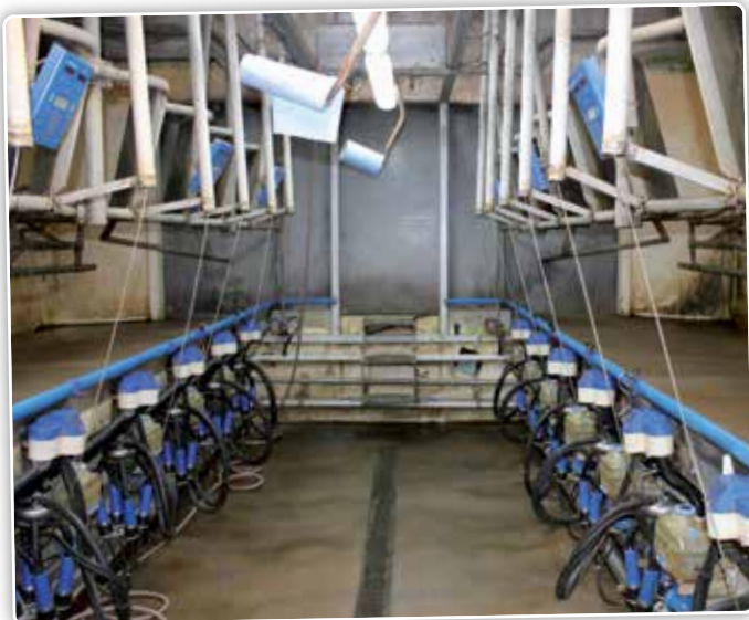
De koeien worden gemolken in een 2x6-melkinstallatie van SAC.
