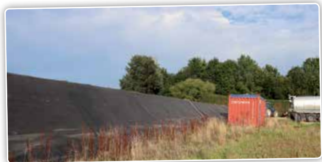
Om de bacteriën in de biofilter in leven te houden is het belangrijk om continu te bevochtigen. Dit wordt een biofilter genoemd naar de actieve bacteriën die automatisch ontstaan in de filter.
