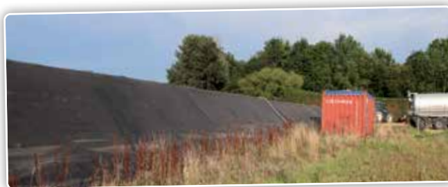
Pour maintenir les bactéries en vie, il est important d'humidifier continuellement. C'est ce qu'on appelle un biofiltre, grâce aux bactéries actives qui apparaissent automatiquement dans le filtre.
