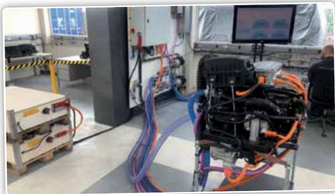
Une pile à combustible Hyundai assure les besoins en énergie.
