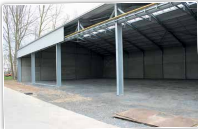
Les nouveaux bâtiments vont permettre de travailler plus efficacement.
