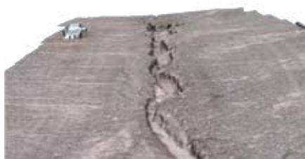
Modélisation 3D de l'érosion sur base de la collectes de données obtenues via un drone.
