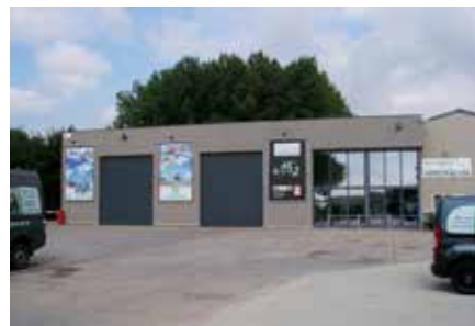
De gebouwen dateren van 2000 en 2008 en bevatten een winkel, werkplaats, magazijn en kantoorruimte.
