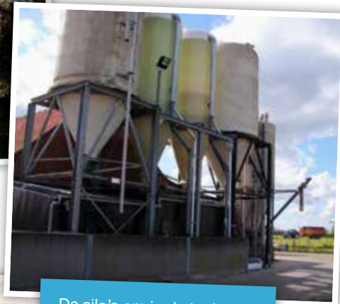
De silo's om in de toekomst zelf de krachtvoerders te gaan mengen.
