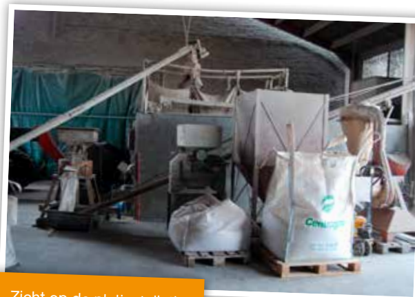
Zicht op de pletinstallatie
