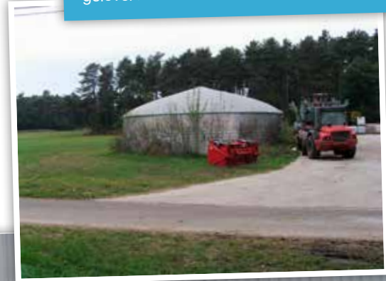
Stroom voor de droogschuur kan geleverd worden door de pocketvergister.
