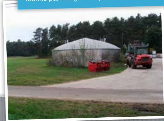
L'électricité pour l'installation de séchage est fournie par le digesteur présent sur l'exploitation.
