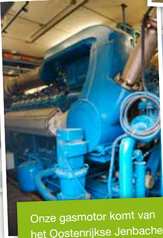
Naast het digestaat kunnen de landbouwers ook dikke fractie afnemen, meestal in de zomer.
