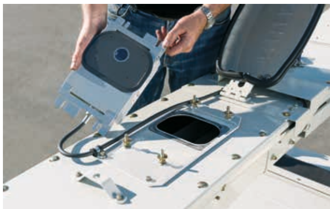
↳ De NIR-sensor op de uitwerppijp van de Claas hakselaar is via een glasvezelkabel met de spectrometer in de cabine verbonden.
