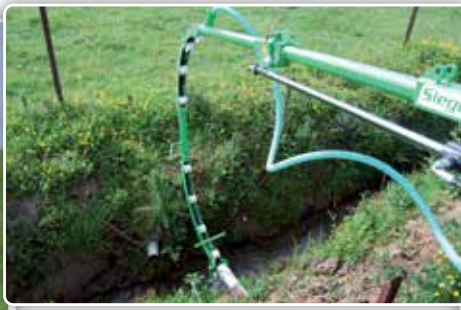
Het water wordt gebruikt om de drainagebuizen schoon te spuiten, maar ook om de HPE-slang nat te houden zodat deze gemakkelijker in de buizen glijdt.
