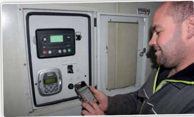
De beregeningspomp met app scheelt in het hoogseizoen zowat 5 uur per week aan arbeid. Dat komt omdat Huijbregts of een medewerker niet continu heen en weer hoeven te rijden tussen de pomp en de haspel van de installatie die ongeveer 40 kilometer verderop op de Belgische landerijen staat.
