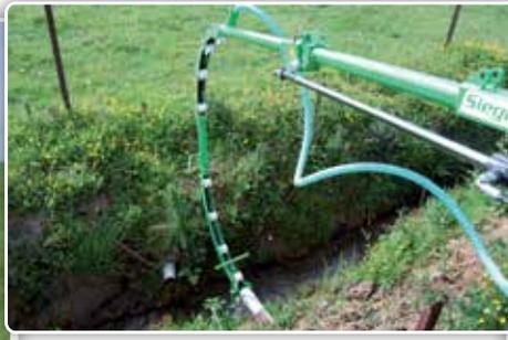
L'eau est utilisée pour nettoyer les conduites de drainage, mais aussi pour humidifier en continu le tuyau HPE afin qu'il glisse plus facilement dans les conduites.
