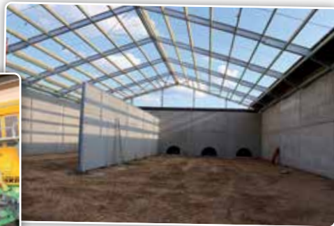
Bij de bouw van de tweede aardappelloods viel de keuze op een volle vloerplaat met verplaatsbare ventilatietunnels.
