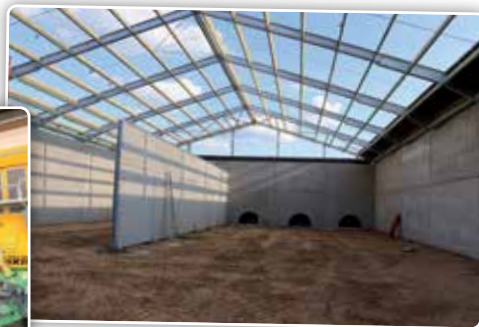
Lors de la construction du deuxième hangar à pommes de terre, le choix a été fait pour une dalle de sol complète avec des tunnels de ventilation mobiles.
