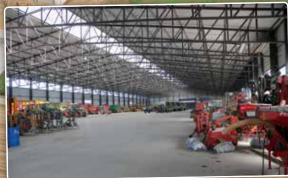
Un fait marquant dans l'histoire de l'entreprise agricole Reiff est le déménagement vers le nouveau site en 2008. Les nouveaux bâtiments offrent une superficie couverte de plus de 16.000 m².
