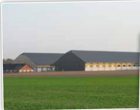
Les deux hangars forment chacun une aile de cette nouvelle ferme brabançonne en carré.
